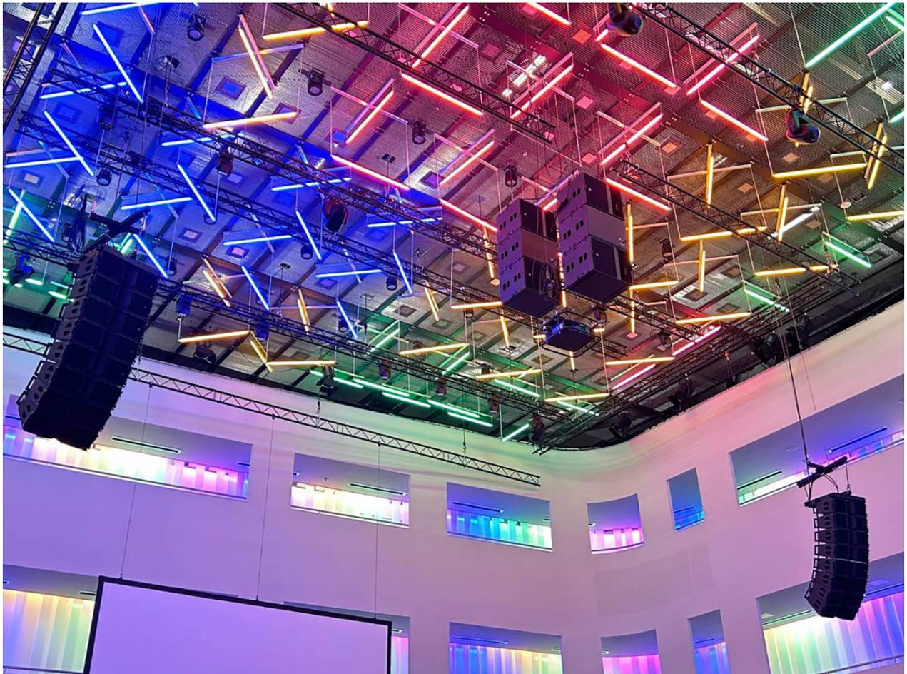
ます。5台の5XTは最前列のカバレッジとイメージングを提供します。ホールには2つのバルコニーがあり、白い5XTとA10iの分散システムでカバーされ、建築とうまく調和しています。P1プロセッサーはLA4XとLA7.16iアンプリファイド・コントローラーとのMilan-AVBネットワークを構築します。
