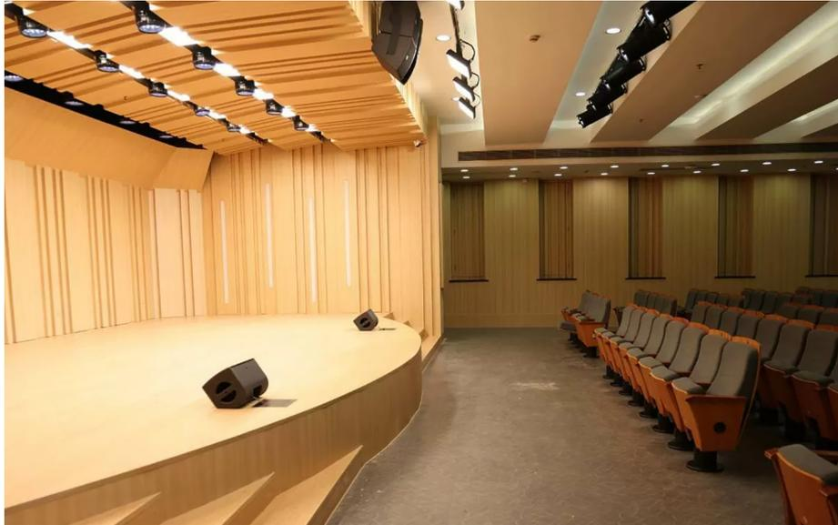
アコースティック処理のおかげでホールの残響時間を最小限に抑えることができ、コンサートグレードの音響システムがライブ・レコーディングやポスプロのスタジオのようなパフォーマンスと一貫性を実現できるようになりました。そこでRACは、L-Acoustics AシリーズのPanflex 水平指向性制御を活用した、A10i Wide と Focus によるLCRデザインを提案し、ホール全体に一貫したサウンド・カバレッジを可能にしました。L-Acoustics KS21 サブウーハーは低域を補強し、X8 コアキシャルスピーカーはステージモニタリング用に舞台の端に設置されました。設置後、L-Acoustics P1 を使ってシステムチューニングが行われました。
