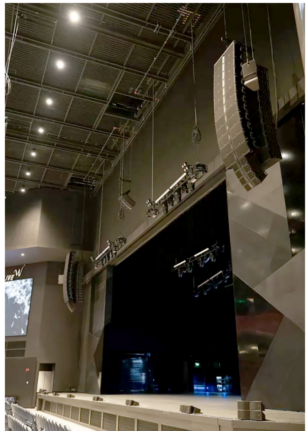
メインシステムの様子。12台のK2の下に、4台のKara IIが使用されています。センタークラスターとして4台のKara IIIもフライングされています。
