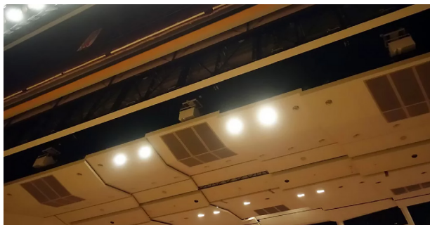
プロセニアムにL、C、R構成で配置されたA15iWide
